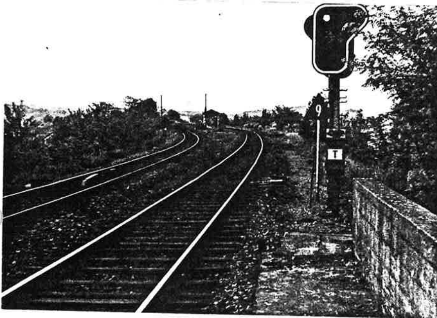
Exemple d'assiette de voie en remblai (L24 sortie viaduc de la gare côté Aachen)
